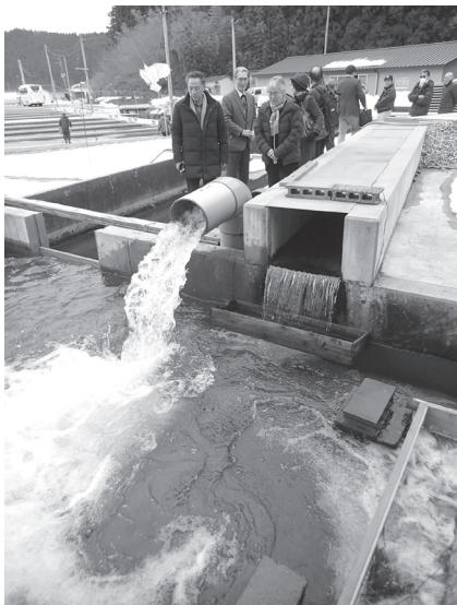
写真3 豊富な鳥海山からの伏流水を湛える新柘川ふ化場
